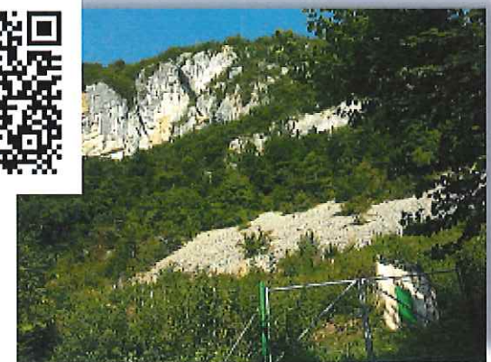
Zone de captage des eaux du village de Lathuille
